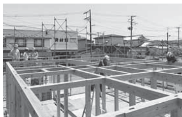
建築現場を見学
