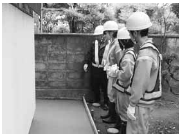
現場確認作業
