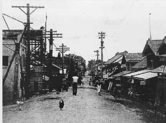
昭和初期の仲町・北町の街並み向かって左手前が昔の郵便局。その奥が建設中の平和館
